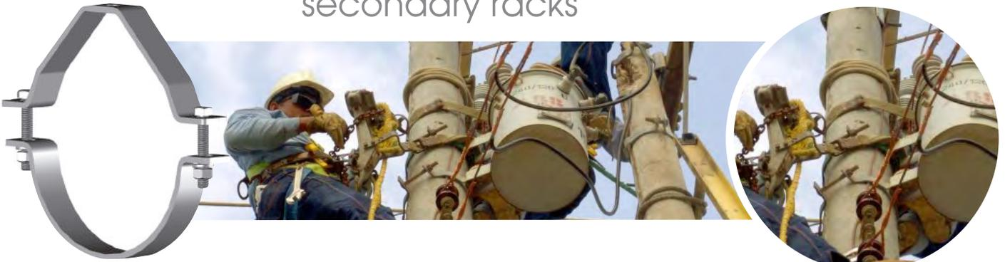
**Uso** Fijar Bastidores B, Soportes SPA, Alfileres P y Soportes angulares V, en líneas y redes de 102 distribución.
